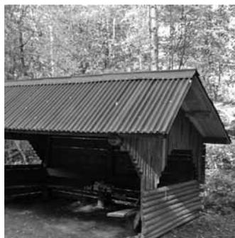
Das Dach der Grillhütte auf dem Grillplatz „Steinbruch“ in Stetten wurde durch Witterungseinflüsse stark in Mitleidenschaft gezogen. Eine Holzpfette war nicht mehr tragfähig und musste ausgetauscht werden. Die Verbretterung sowie die Bitumenwellplatten wurden erneuert. Somit ist die Hütte wieder wetterfest und bereit für die nächste Grillsaison.
