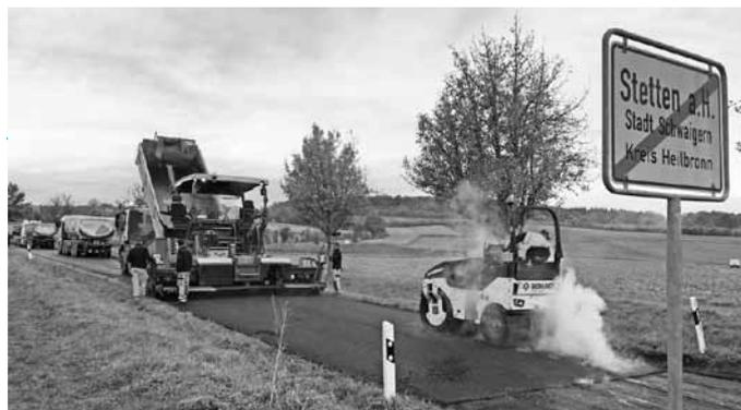
Derzeit erfolgt der Einbau von zwei Asphaltsschichten im sogenannten „Hocheinbau“.
