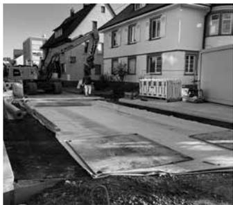
In der letzten Woche wurden die neuen Leerrohre für das Rückverlegen der Glasfaserleitungen der Deutschen Telekom und Vodafone GmbH verlegt, sowie Vorbereitungen zum Erneuern eines Teilstücks der Gasleitung getroffen. Die Leitungsarbeiten sind derzeit im Gange. Auch die Baugruben für die Verlegung der Wasser-
